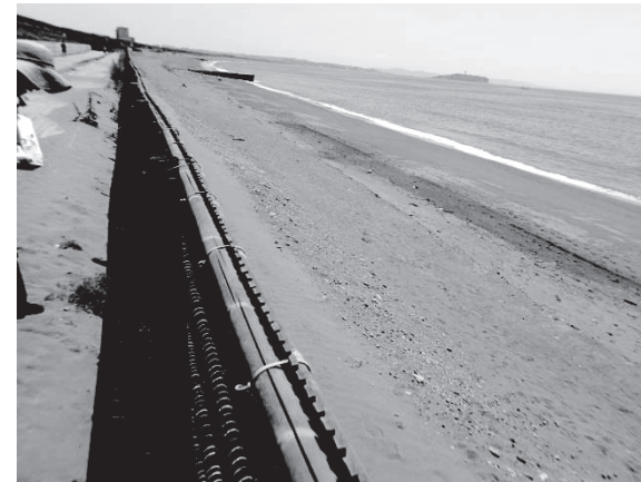
写真 4 調査地 S31-S36 海側 2013.5/24 養浜整備がされており, 植物は砂防柵の脇に 見られる程度。
