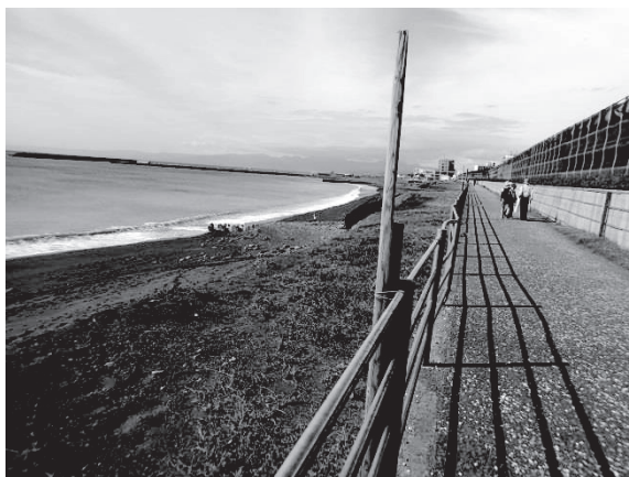
写真 5 調査地 S37-S45 2013.10/18 左の海岸側は養浜により砂を 2 段積み れている。歩道, 砂防林手前柵, 柵内には 低木, 防風ネットで囲われたクロマツ 砂防林。
